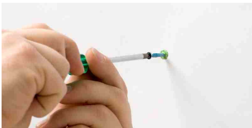
Wkręcanie śrub w kołki
